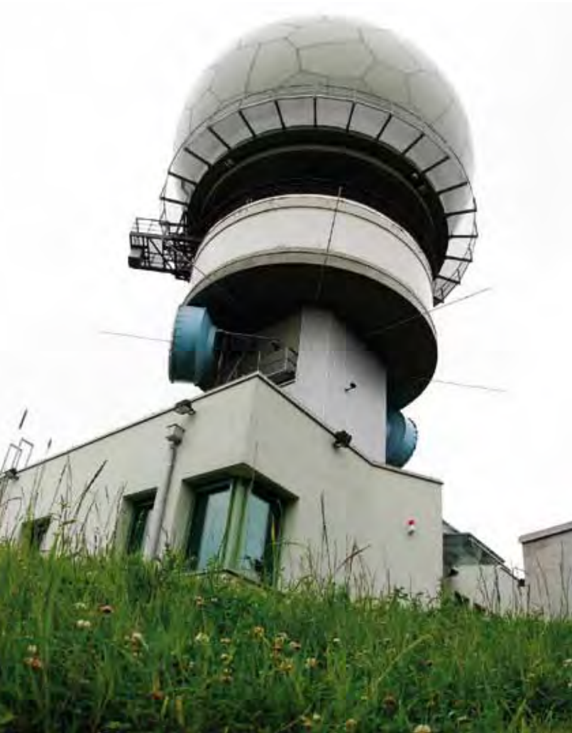
Die Wahrung der Lufthoheit wird im Zusammenwirken zwischen aktiven und passiven Mitteln der Luftraumüberwachung (im Bild die modernisierte Radarstation Steinmandl im niederösterreichischen Weinviertel) sichergestellt.
